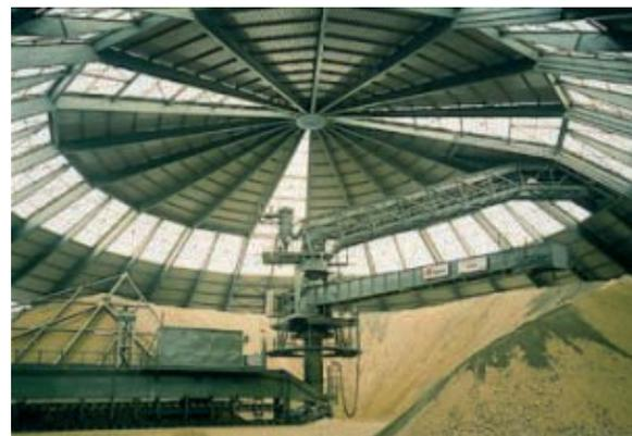
Nave cubierta para la preparación del crudo
