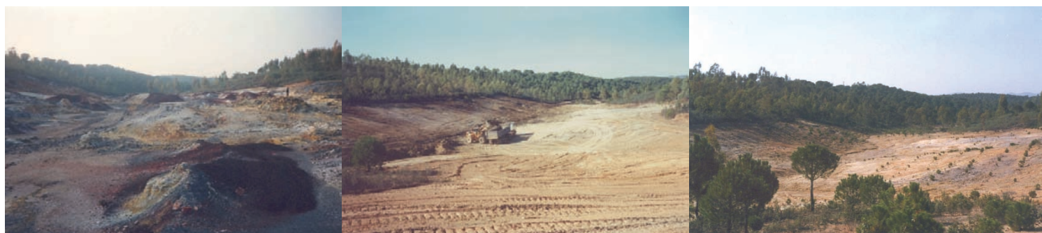
Para la restauración de esta mina, primero se retiraron los residuos, después se acondicionó el terreno y, por último, se plantaron pinos, que es la vegetación del entorno de la explotación.
