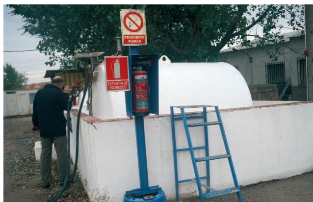
Los depósitos de combustible se instalan en el interior de una especie de piscina de hormigón, llamada cubeto, que sirve para recoger los vertidos accidentales de combustible, y evitar que contaminen el suelo o las aguas.
