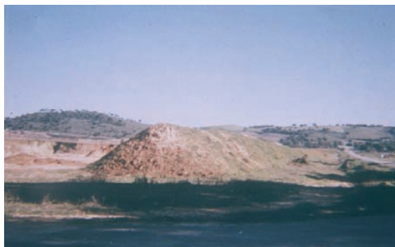
Pantalla visual construida con tierra vegetal acopiada para su uso posterior.
