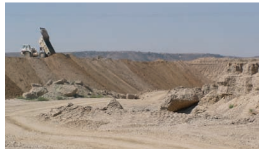
Operación de relleno de un hueco con estériles.
