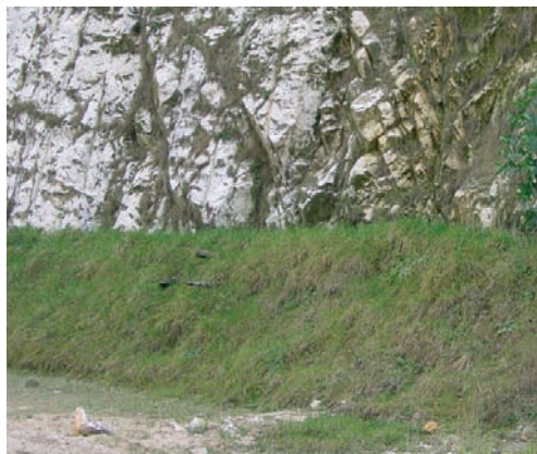
Para la hidrosiembra de los frentes rocosos se utilizan semillas de plantas rupícolas y productos que dan a la roca un aspecto envejecido.
