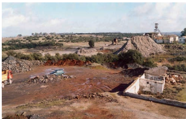
Mina metálica abandonada en la que han quedado numerosos restos de estructuras e instalaciones, una balsa de residuos, escombreras, etc.
