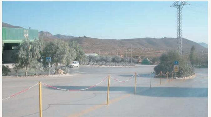
Reductores de velocidad en las zonas de paso de los camiones bañera; a menor velocidad se produce menos polvo en las zonas de paso. (14)
