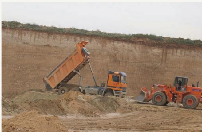
Relleno del hueco con estériles inertes
