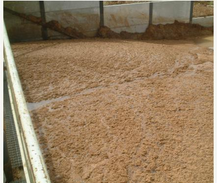
Sistema compacto de separación de la fase sólida y líquida. Módulos alternativos. (72)
