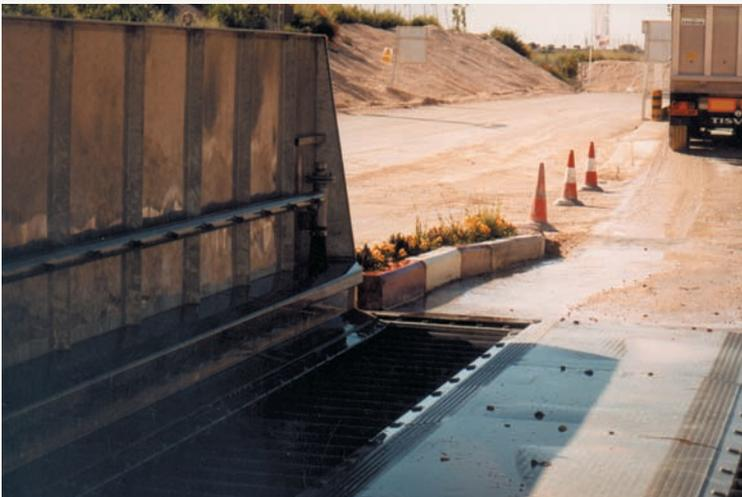
Dispositivo para el lavado de camiones con recogida del agua sucia y sistema de separación de hidrocarburos. (68)
