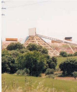
Reducción del impacto visual utilizando el hueco de la cantera para ubicar la planta de tratamiento
