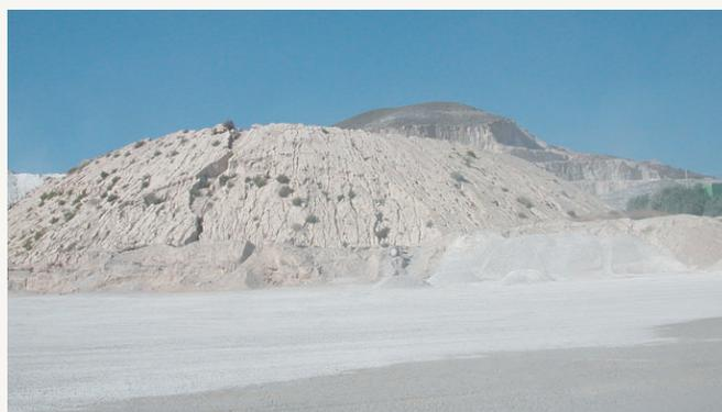
Barrera física formada por material de rechazo no utilizable y matorral, p. ej.: arena de bajo equivalente, inertes, ... (2)
