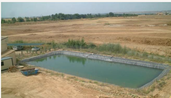
Balsa de aguas limpias con solera de geotextil y vallada
