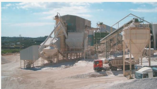
Carenado de la planta de tratamiento con captación de polvo mediante aspiración y filtros de mangas: minimización de la emisión de polvo y mejora de calidad de áridos por la captación de Filler. (7)
